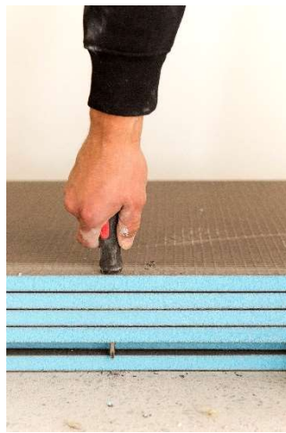
Kuva 2. Reiät kiinnikkeille
