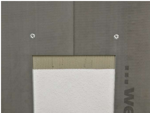
Kuva 1. Laastipeittokiinnitys + kiinnikkeet
